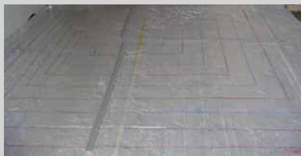
شکل ۱) آرایش لوله‌ها با استفاده از خط کشی بر روی عایق کف و لایه محافظ متالایز
